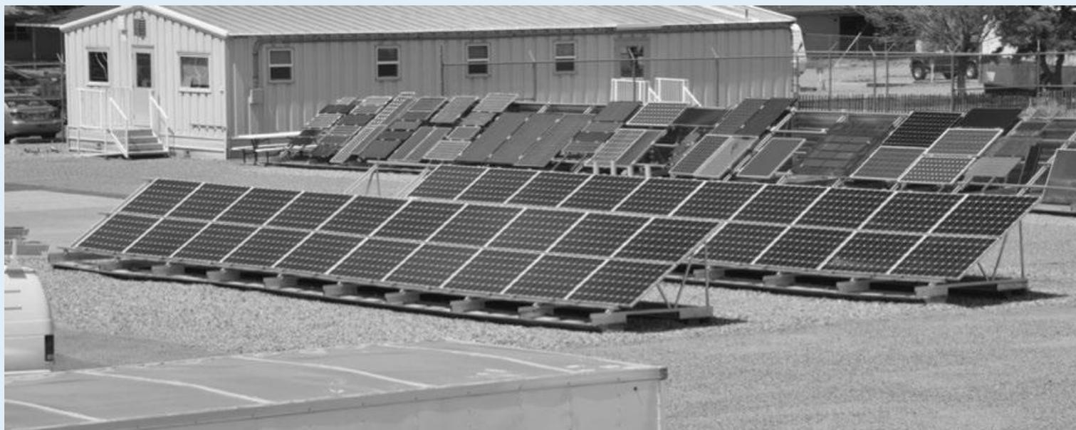
**PV array – 10.8kWp; 4x10 modules
